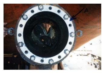
Reparatur an zwei Propellerwellenaußenlagerungen mit MM-metall SS-StahlKeramik, Härter gelb und Härter grün. An beiden Seiten der Lagerung wurde ein Ring mit genauem Innendurchmesser des Lagers angeschraubt. Dieser Ring wurde nach der idealen Wellenachse zentriert. Anschließend wurde MM-metall SS-StahlKeramik appliziert und achsparallel glatt gezogen.
