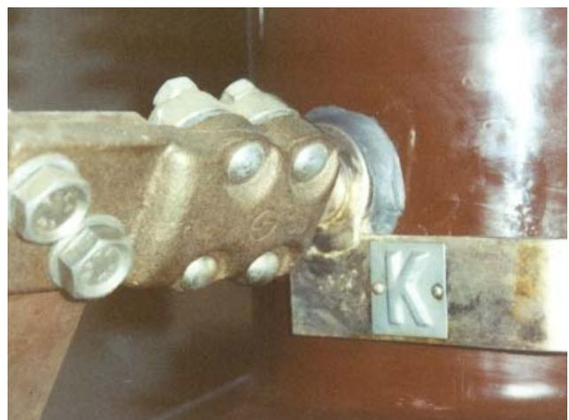
Zur Vermeidung von Ölundichtigkeiten an Stromwandlern wurden die Bolzen mit MM-metall oL-StahlKeramik und Härter gelb eingesetzt.
