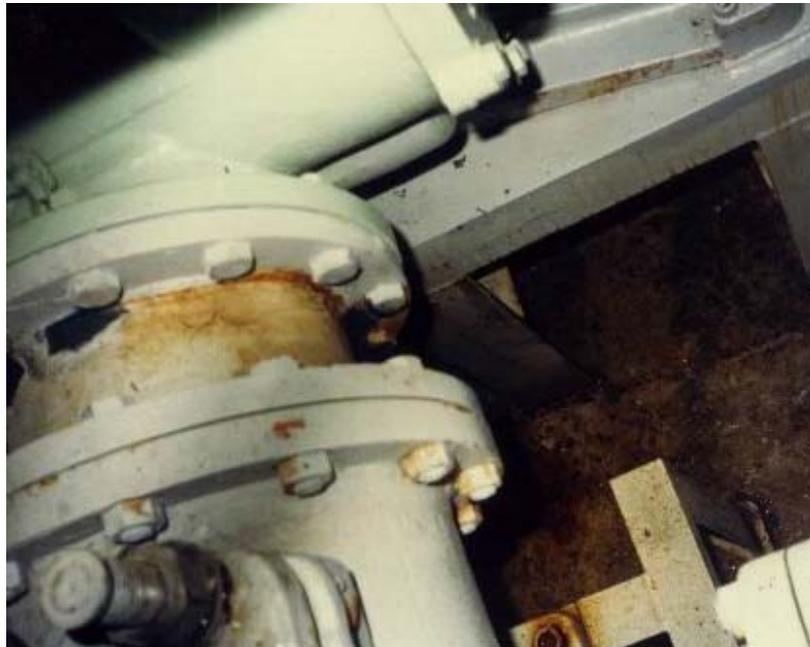
Die undichte Schweißnaht einer Seewasserpumpe wurde mit MM-metall UW und Härter UW9 abgedichtet.
